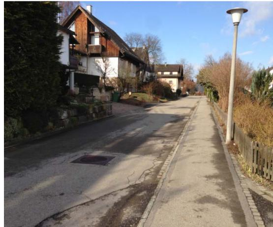
Der Sanierungsbereich beinhaltet deshalb den abschnittswisen Ersatz der Fundationsschicht sowie des gesamten Belages (Trag- und Deckschicht). Zudem werden ein Grossteil der Randabschlüsse sowie sämtliche Ablaufabdeckungen ersetzt.
