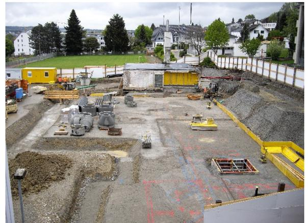
Vorbereitungsarbeiten für den Einbau der neuen Betonplatte und die Erstellung der Frostriegel. (27. April 2017)
