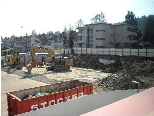
Die Turnhalle wurde fertig abgebrochen bis die Bodenplatte zum Vorschein kam. Diese wird später demontiert. (28. März 2017)
