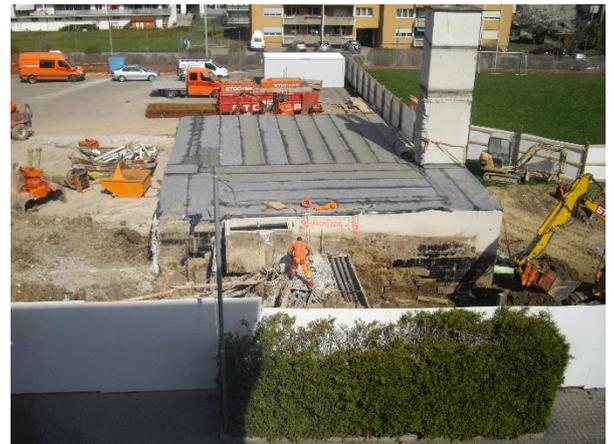
Ein Bauarbeiter befreite die Kabel von Beton. Das Dach wurde abgedichtet, damit kein Regen an die darunterliegende Heizzentrale gelangt. (29. März 2017)
