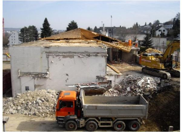
Das Holz wird vom Beton getrennt und anschliessend entsorgt oder teilweise recycelt. (15. März 2017)
